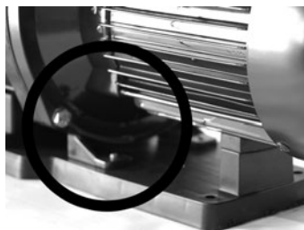
Regularnie sprawdzaj szczelność! Wyciek z uszczelnienia mechanicznego powoduje poważne uszkodzenia!
